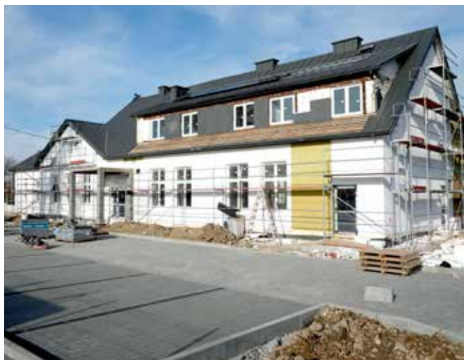
Postęp prac remontowo - adaptacyjnych w budynku komunalnym w Strzelcach Małych
