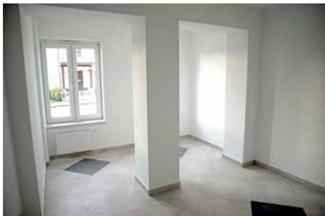
Jedno z wyremontowanych pomieszczeń
