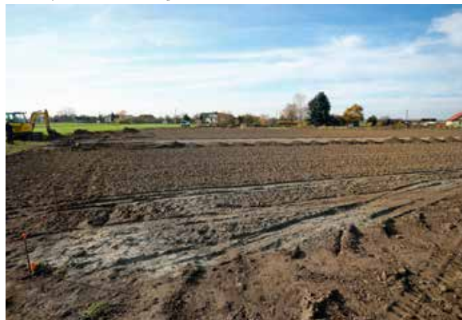
Boisko sportowe w Woli Przemyskiej w trakcie prac modernizacyjnych
