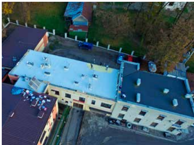
Dach na budynku komunalnym w trakcie realizacji prac
