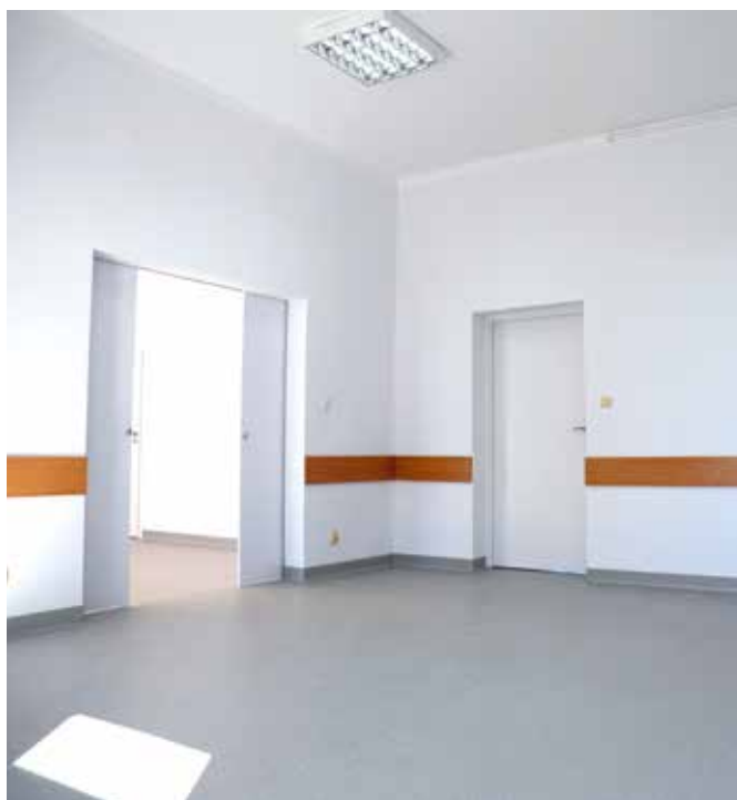
Wyremontowane i dostosowane pomieszczenia pod działalność placówki
