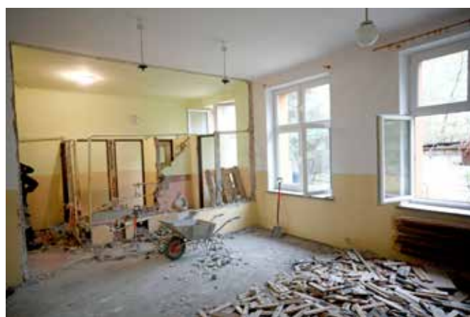
Rozpoczęte prace remontowe wewnątrz budynku
