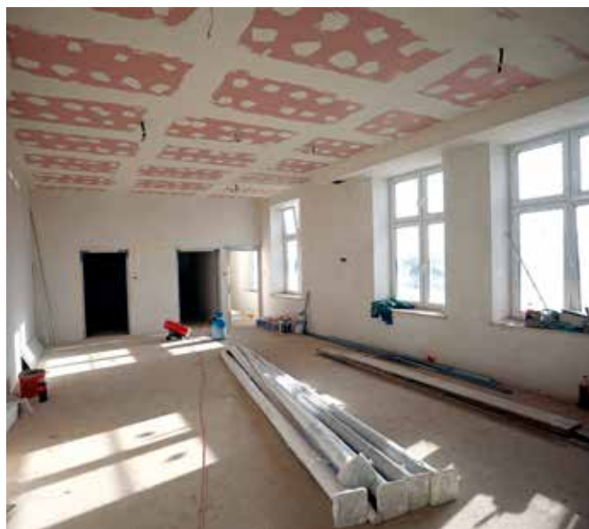
Postęp prac remontowo - adaptacyjnych w budynku komunalnym w Strzelcach Małych
