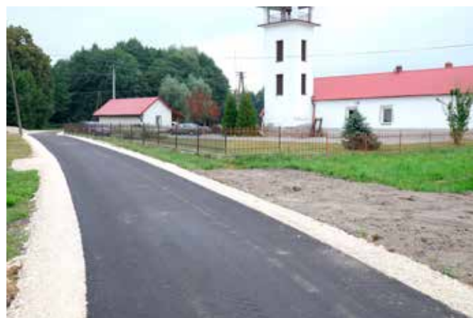
Zmodernizowana droga w Pojawiu
