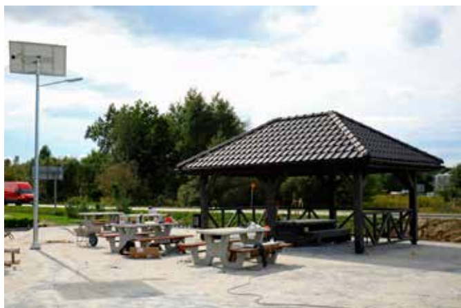
Prace w powstającym punkcie w Niedzieliskach
