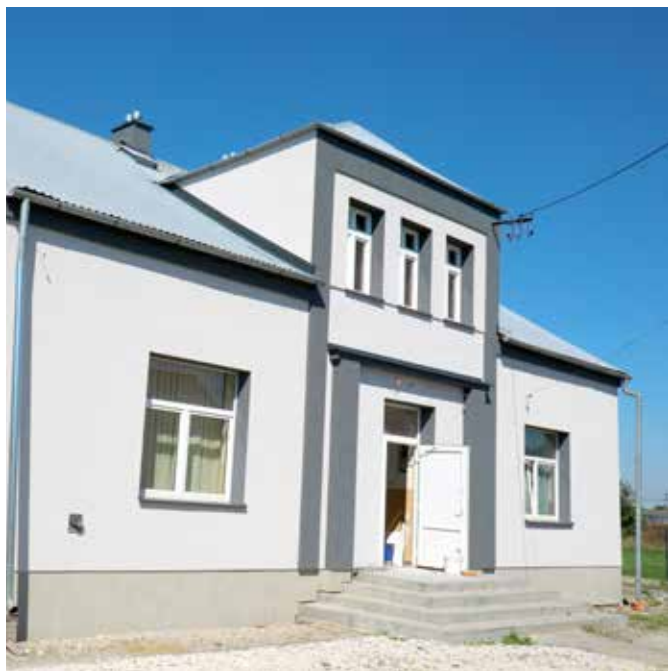
Realizowane prace w Domu Ludowym w Szczurowej - Włoszynie
