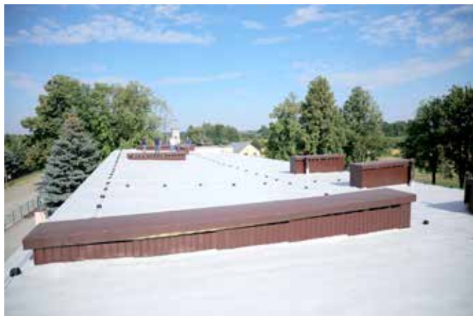
Zmodernizowany dach na budynku szkoły w Woli Przemyskiej
