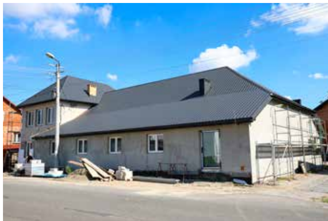
Trwające prace w Domu Ludowym w Niedzieliskach
