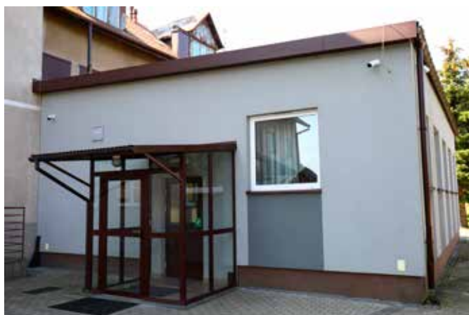
Instalacja monitoringu na budynku sali przy szkole we Wrzępi
