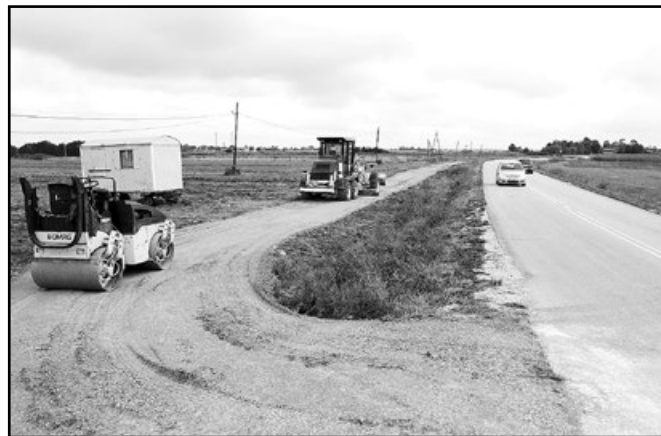
Budowa jednej z dróg w ramach zagospodarowania poscaleniowego.
