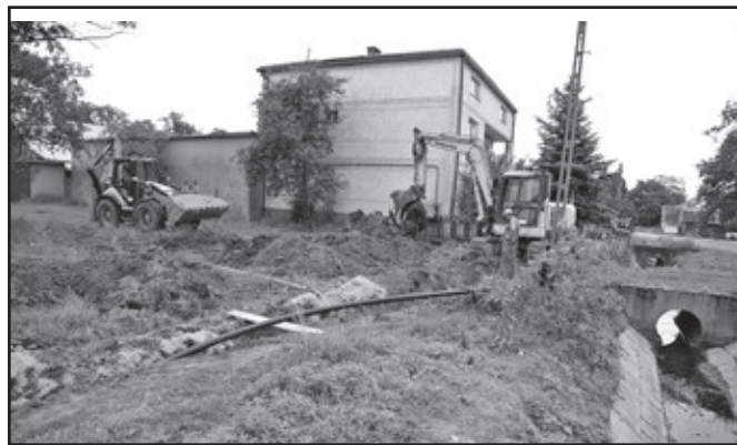
Prace ziemne w Niedzieliskach
