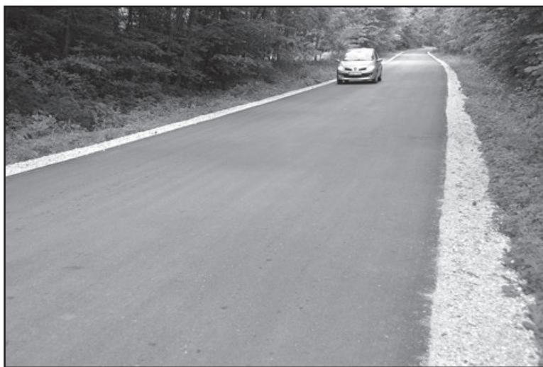
Pojawie. Nowa nawierzchnia na końcowym odcinku drogi od mostu na Wiśle w Górcie do Wał-Rudy.
