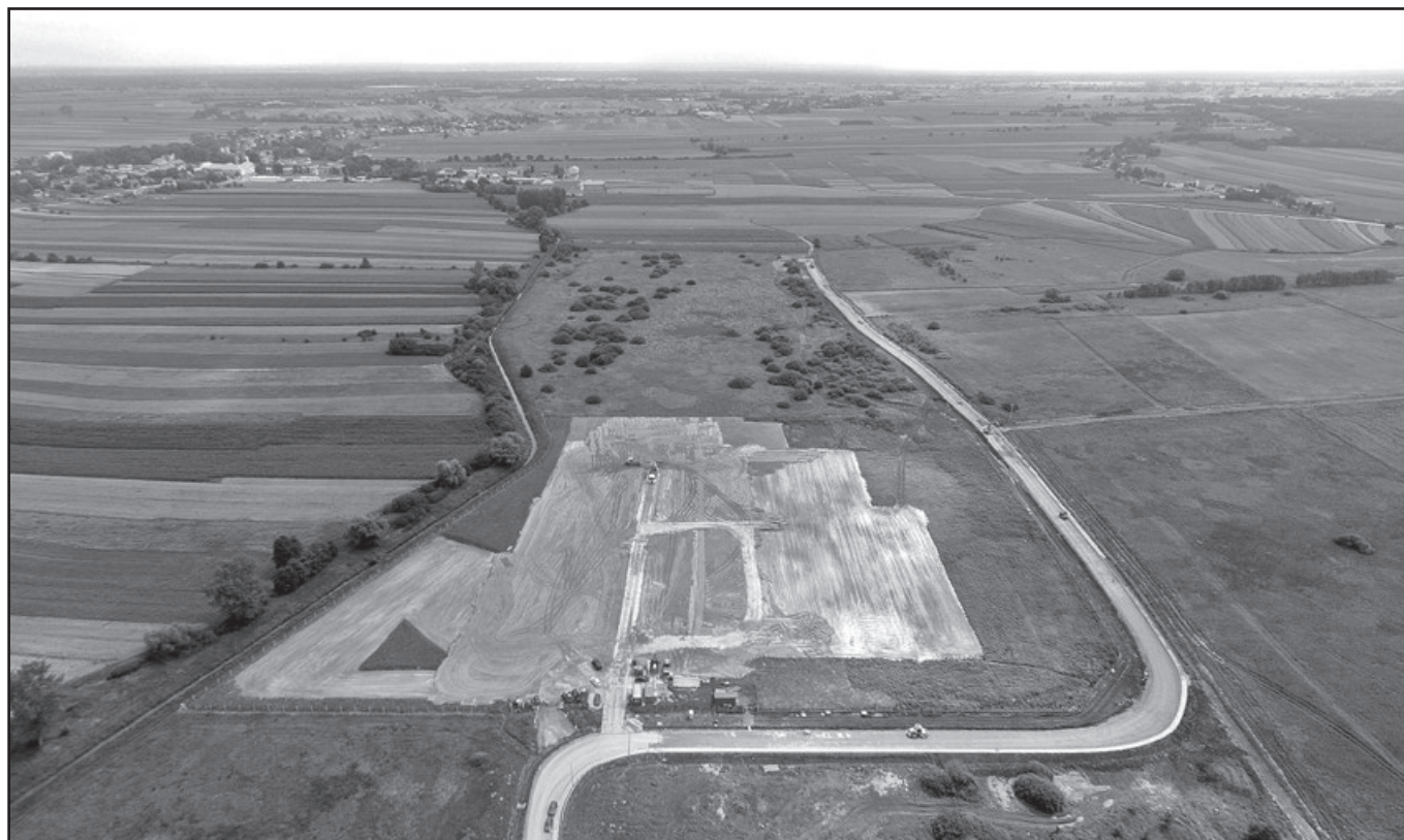
Kolejny etap budowy szczurowskiej Strefy Aktywności Gospodarczej (widok z drona).
