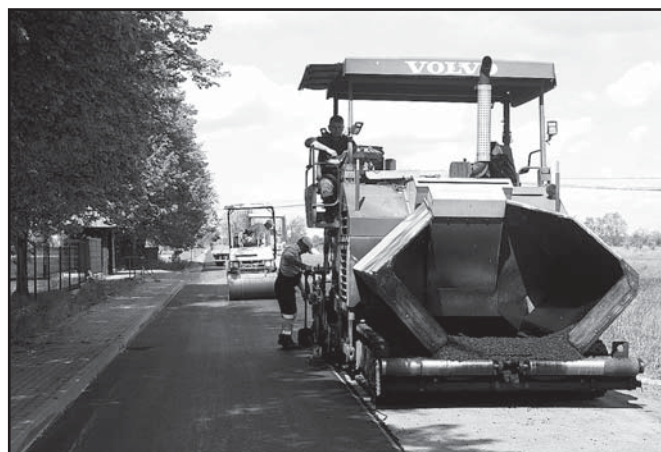
Generalny remont drogi w Woli Przemyskiej.
