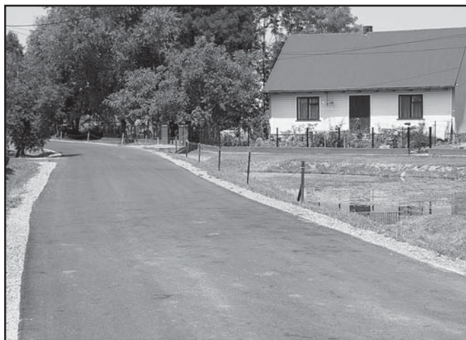
Nowa nawierzchnia na drodze powiatowej we Wrzępi.
