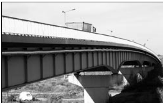
Rura wodociągu wzdłuż mostu na Wiśle.
