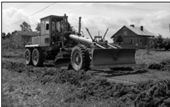
Budowa drogi w Woli Przemyskiej.
