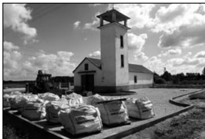
Budowa centrum wsi w Pojawiu.
