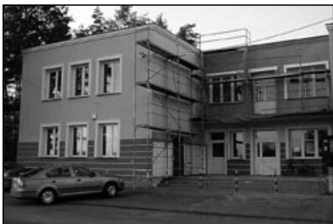
Pojawie. Modernizacja Domu Ludowego.
