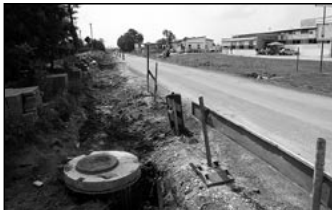
Budowa kanalizacji sanitarnej.
