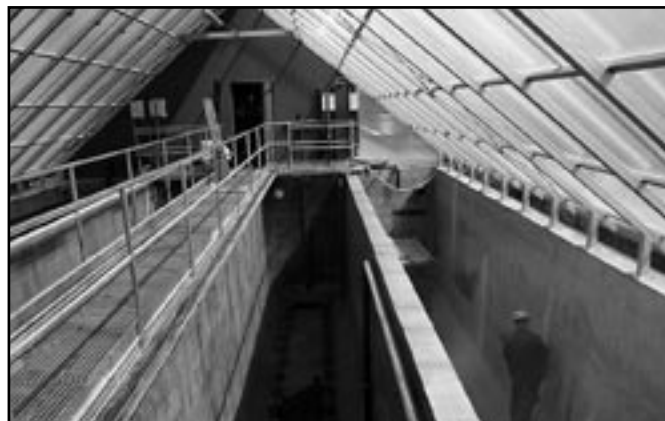
Prace przy modernizacji oczyszczalni.
