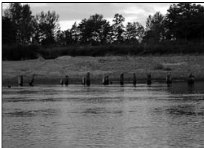
Pozostałości filarów mostu w Natkowie.
