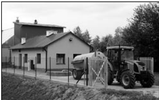
Oczyszczalnia ścieków w Szczurowej.
