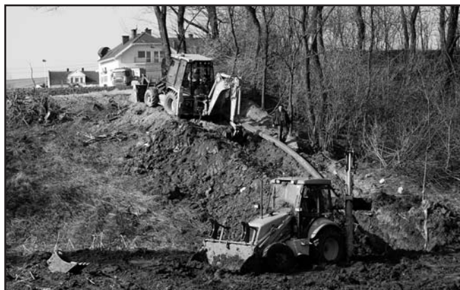
Sokołowice, kwiecień 2011 r. Budowa linii przesyłowej wody w kierunku Wisły, która będzie przebiegać pod dnem rzeki.
