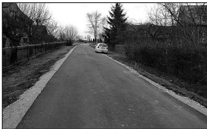
Nowa nawierzchnia na drodze gminnej w Woli Przemysłowskiej.
