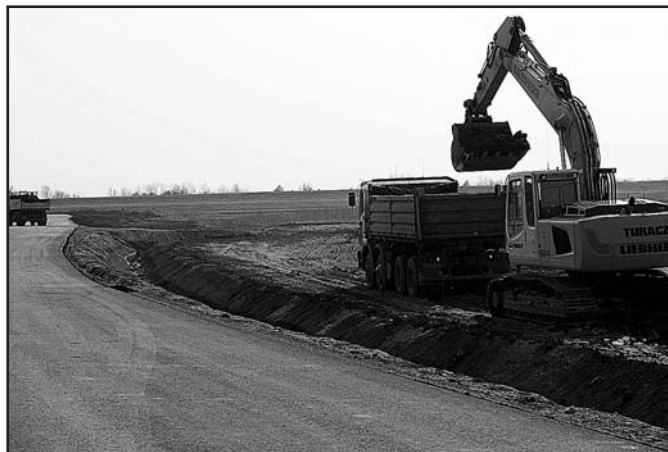
Rząchowa. Budowa nowej drogi od mostu w Górcie.
