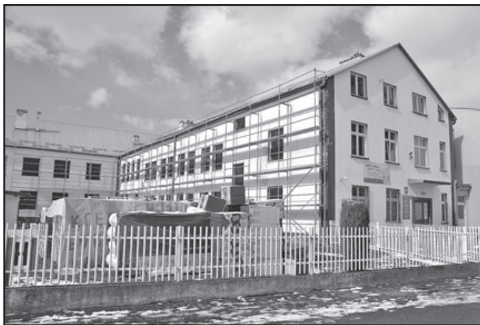
Remont generalny szkoły w Szczurowej za ponad 3 mln zł.
