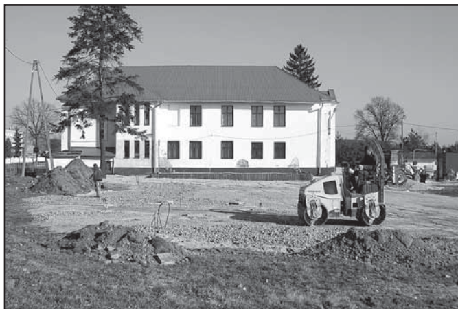
Prace przy Domu Ludowym w Zaborowie.
