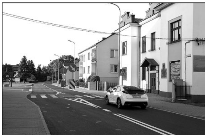
Droga powiatowa w Uściu Solnym.
