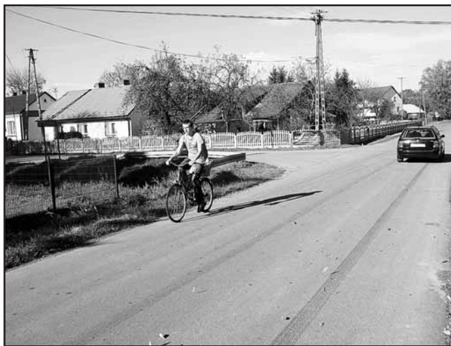
Droga przez Dołęgę to jedna z wielu dróg powiatowych zmodernizowanych w mijającej kadencji.
