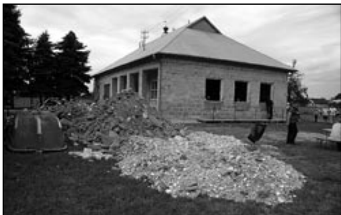
Remontowana remiza OSP w Natkowie.
