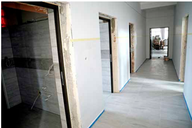
Pomieszczenia w GCKCzIS w trakcie prowadzonych prac remontowo - modernizacyjnych
