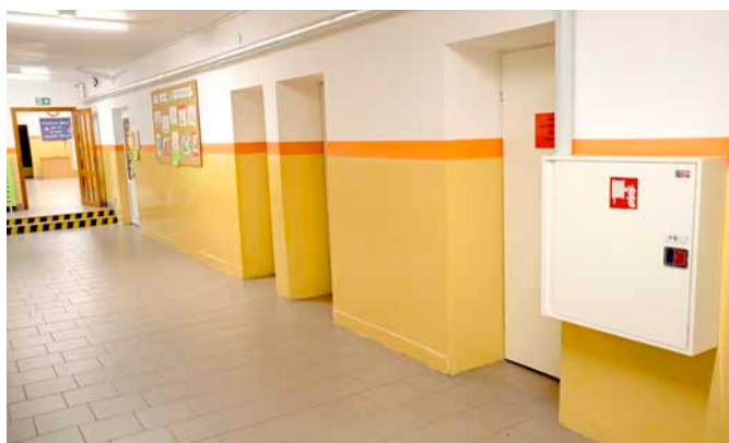
Jeden z kilku wykonanych hydrantów przeciwpożarowych
