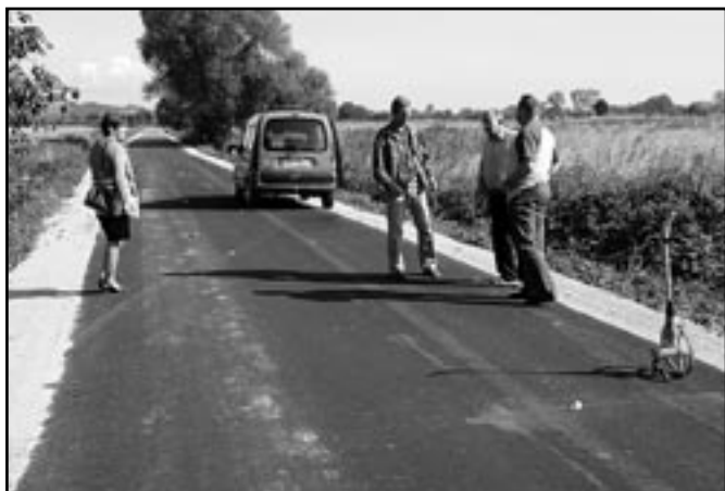
Nowa nawierzchnia na drodze ze Strzelec Małych do Barczkowa.
