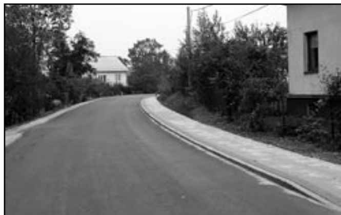
Naprawiony chodnik w centrum Górki, który uległ zniszczeniu podczas ubiegłorocznej akcji powodziowej.
