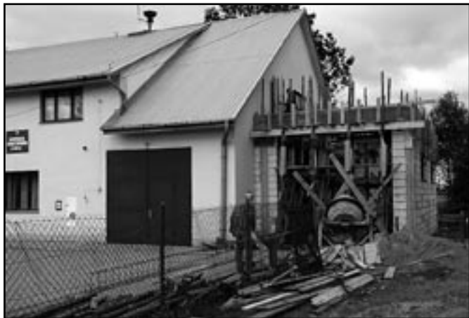
Rozbudowa remizy OSP w Górcie.
