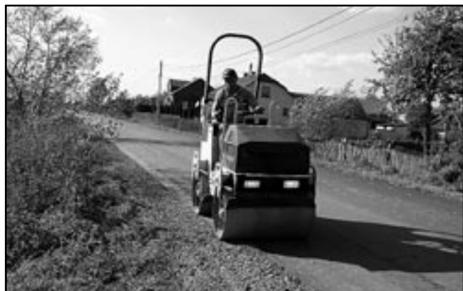
Wykonywanie poboczy w Kwikowie to prace wykończeniowe dwuletniej inwestycji.
