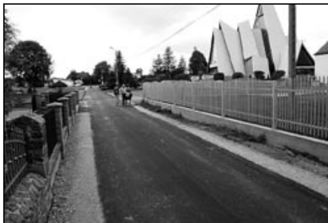
Nowa droga asfaltowa w centrum Rudy-Rysia.
