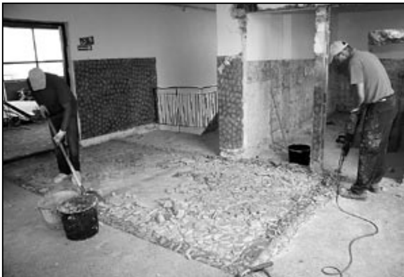
Remont Domu Ludowego w Woli Przemykowskiej.
