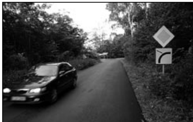
Nowa nawierzchnia asfaltową na drodze z Pojawia w kierunku Jadownik i Wał-Rudy.
