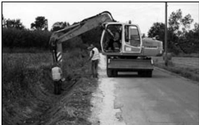
Szczurowa-Brzezinki. Pogłębianie rowów.
