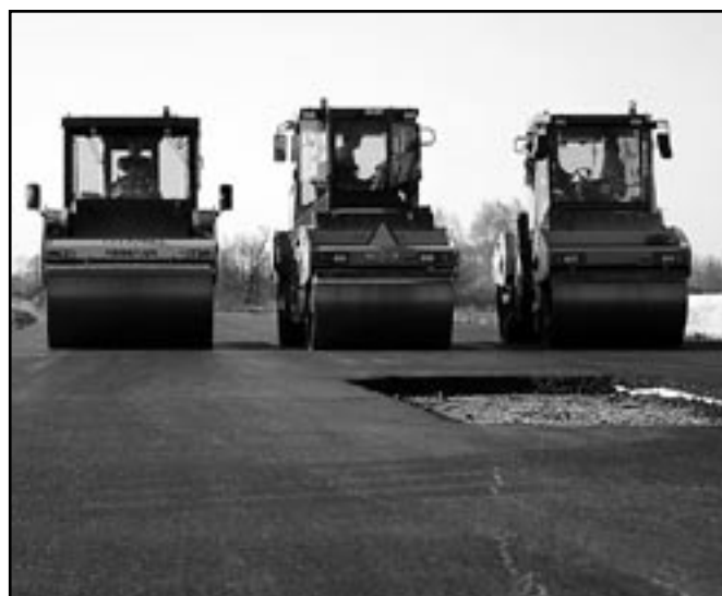
Walce drogowe na budowie w Niedzieliskach.
