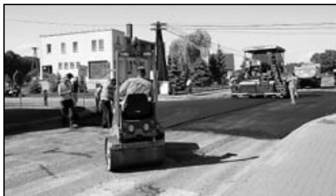
Prace na głównym skrzyżowaniu Zaborowa.
