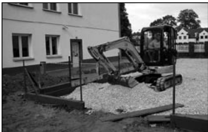
Budowa placu zabaw przy szkole w Szczurowej.
