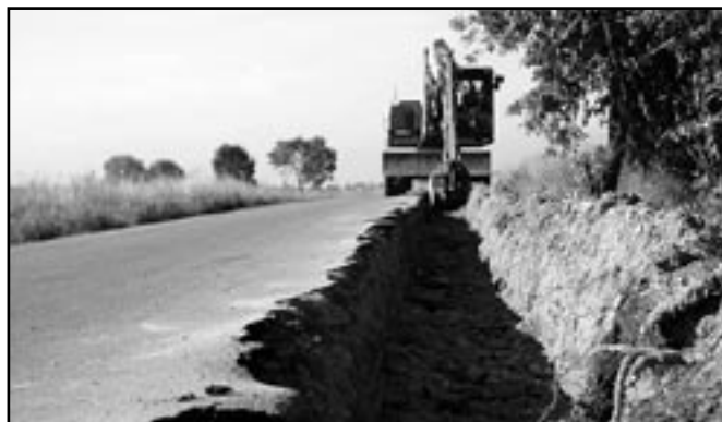
Szczurowa-Brzezinki. Przebudowa drogi gminnej.
