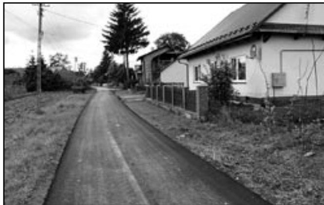
Nowa nawierzchnia na drodze w Uściu Solnym.
