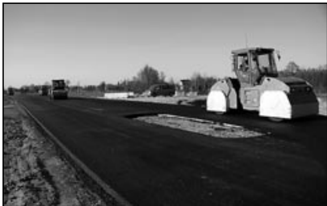
Budowa drogi wojewódzkiej omijającej Niedzieliska.
