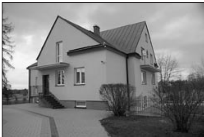
Budynek plebanii po gruntownym remoncie.
