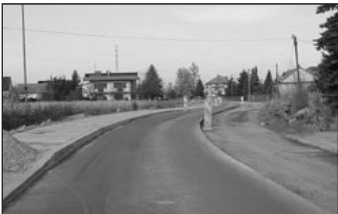
Modernizacja drogi wojewódzkiej w Rylowej.
