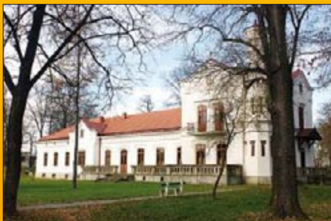
Odrestaurowany dwór w centrum Szczurowej.
