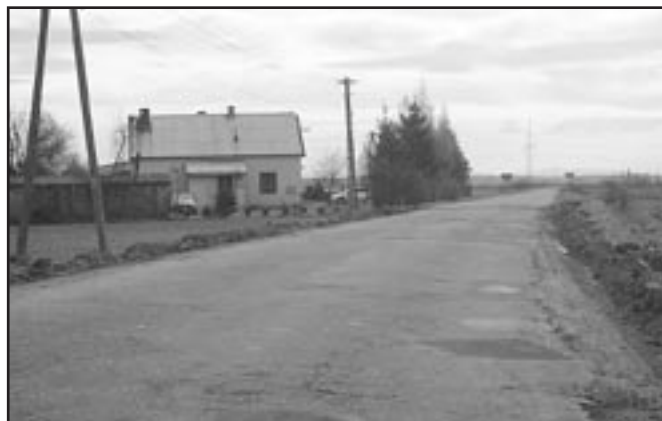
Remontowana droga powiatowa do Wrzępi.
