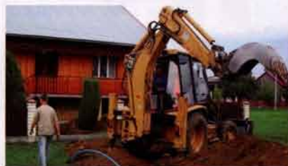
Prace przy budowie przyłącza wodociagowego w Górcie.
