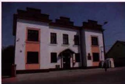
Wykonano remont w budynku grodzkim, parkingi i chodnik do ośrodka zdrowia.
