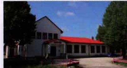
Dom Strażaka i wyremontowana biblioteka w Dołędzie wraz z zadaszoną stylową studnią. Wykonano również remont dawnej szkoły.
