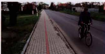
Niedzielska. Nowy chodnik z kanalizacją deszczową przy drodze wojewódzkiej.
