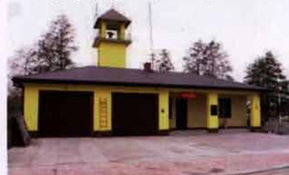
Zmodernizowano remizę OSP w Zaborowie poprzez remont dachu, kominów na budynku, wymianę stolarki okiennej i drzwiowej wraz z bramą garażową, malowanie pomieszczeń.
