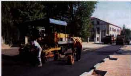
Budowa parkingu przy Urzędzie Gminy w Szczurowej.
