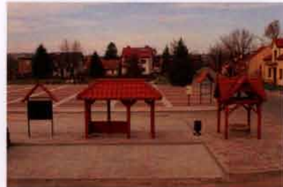
Przebudowana płyta rynku z elementami małej architektury, nowym przystankiem i oświetleniem w Uściu Solnym.
