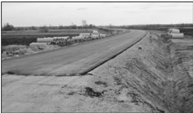
Budowa nowej trasy z Górki do Brzeska.
