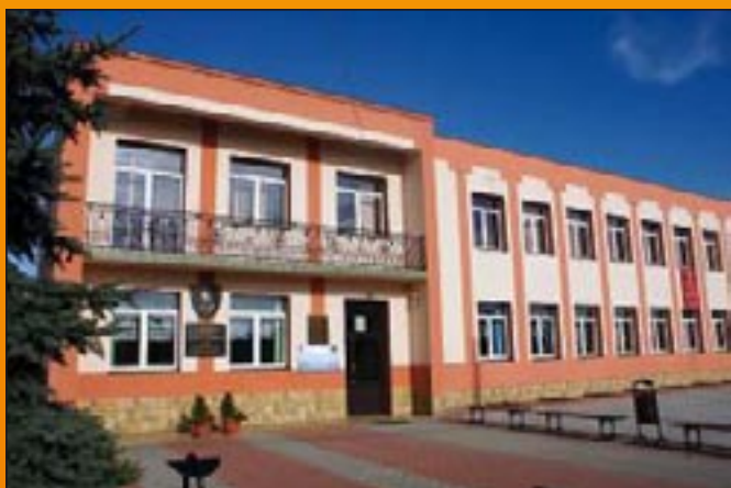
Budynek zaborowskiej szkoły podstawowej i gimnazjum po gruntownym remoncie.
