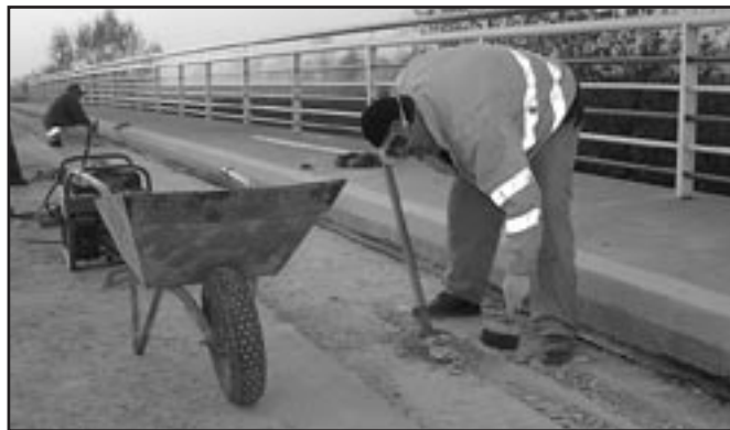
Prace wykończeniowe na moście w Kwikowie.
