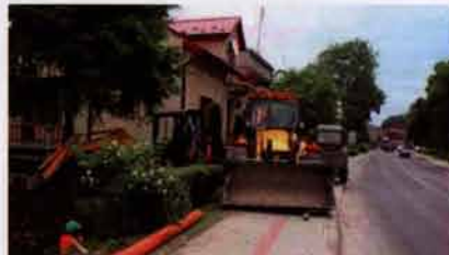
Budowa kanalizacji sanitarnej na ulicy Lwowskiej w Szczurowej, w ramach której podłączono do oczyszczalni ponad 70 budynków mieszkalnych.
