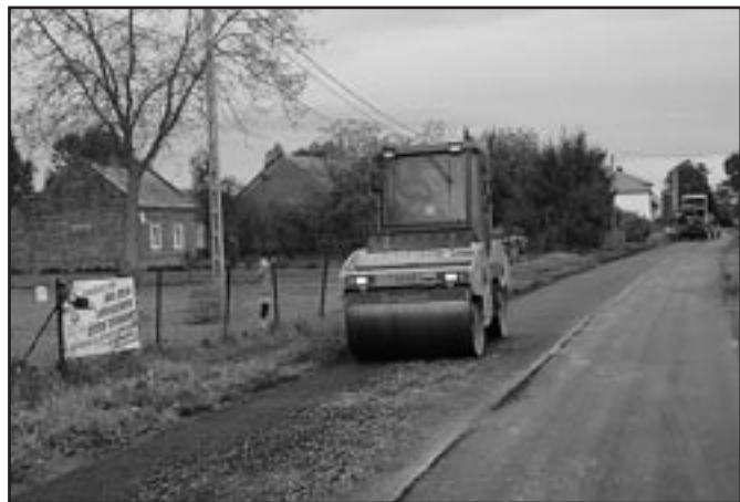
Wykonywanie warstwy podkładu pod nawierzchnię asfaltową na drodze w Kwikowie.
