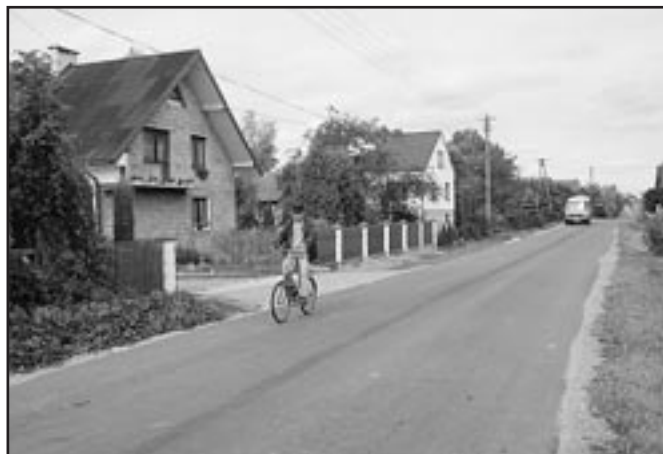
Nowy asfalt w Strzelcach Wielkich to efekt realizacji wniosków mieszkańców tej wsi przez Zarząd Powiatu.
