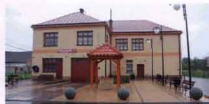
W budynku remizy OSP w Strzelcach Wielkich wykonano remont i ocieplenie ścian zewnętrznych wraz z salą widowiskową i toaletami. Wykonano również remonty bieżące w budynku Domu Ludowego.
