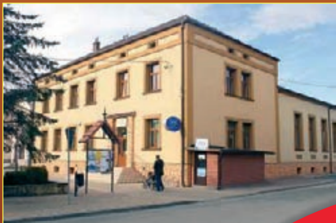
Odnowiony budynek GCKCiS w Szczurowej.
