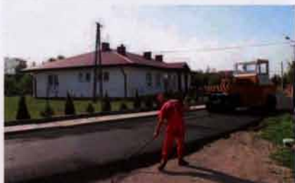
Budowa nowej nawierzchni drogi przy przedszkolu komunalnym w Szczurowej.
