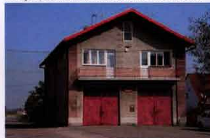
Wyremontowana remiza OSP w Szczurowej wraz z nową kotłownią i nowo otwartym centrum kształcenia przez Internet, które z pomocą środków europejskich wyposażono w niezbędny sprzęt komputerowy.
