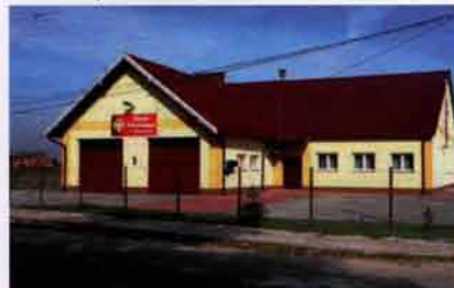
Rozbudowana, ocieplona z pomocą środków WFOS remiza OSP w Ryłowej wraz z zagospodarowaniem terenu wokół obiektu.
