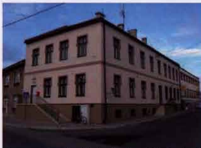
Termomodernizacja budynku wielofunkcyjnego poczty i telekomunikacji w Szczurowej.
