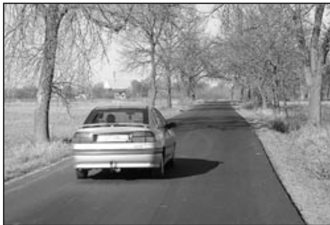
W 2010 r. przybył kolejny kilometr nowej nawierzchni na drodze do Woli Przemyskiej.
