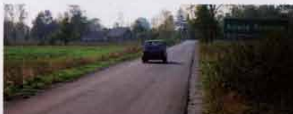
Zmodernizowany odcinek drogi gminnej Księża Kopacze-Kwików.
