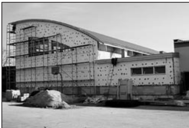
Hala sportowa w Zaborowie w trakcie budowy.
