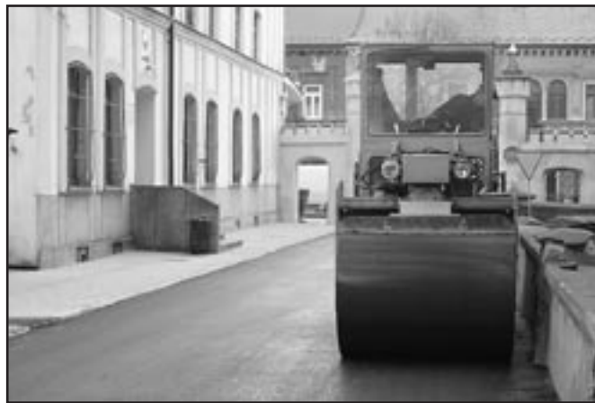
Nowy asfalt na drodze od Urzędu Gminy w kierunku północnym to jedno spośród wielu zadań wykonanych w bieżącym roku na drogach gminnych.
