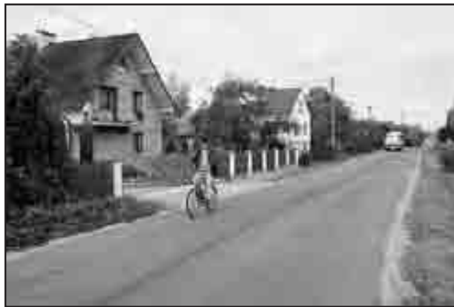
Nowy asfalt w Strzelcach Wielkich.
