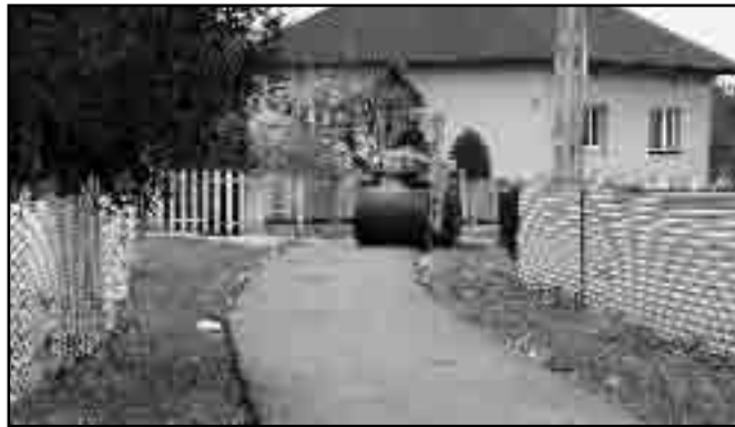
Nowy asfalt w Dołędzie.
