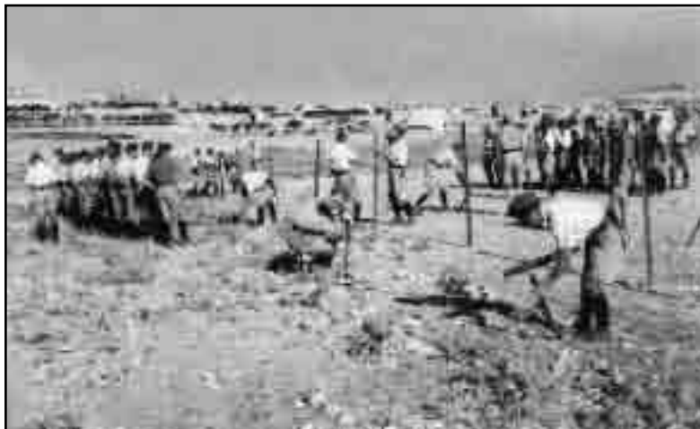
Budowa zasieków z drutu kolczastego. Latrun – wrzesień 1940 r.
