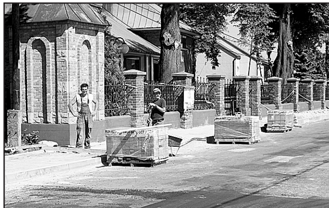
Budowa chodnika w Zaborowie.
