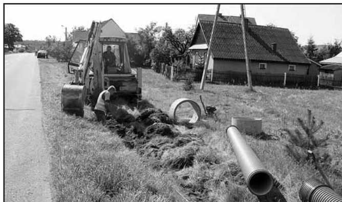
Budowa chodnika w Rudy-Rysiu.
