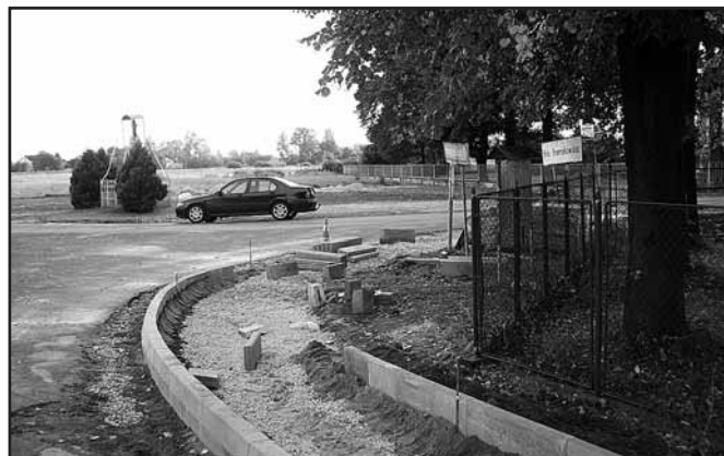
Budowa chodnika w Woli Przemysłowej.
