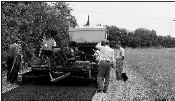
Wykonywanie nawierzchni w Górcie.
