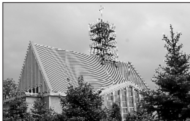
Wieża podczas remontu.
