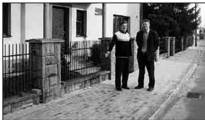
Radny Kazimierz Różycki (z lewej) i członek Zarządu Powiatu Marek Antosz po zakończeniu prac przy budowie pierwszego odcinka chodnika w centrum Uścia Solnego.
