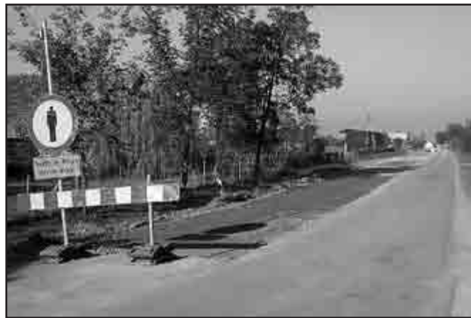
Fragment remontowanej drogi w Strzelcach Małych.
