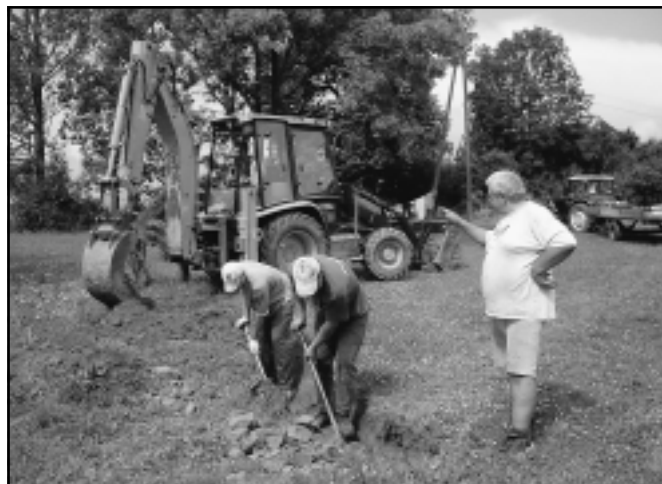
Budowa wodociągu w Ryłowej.
