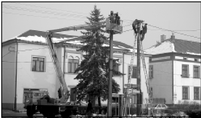
Pierwsze prace przy przebudowie centrum Szczurowej.
