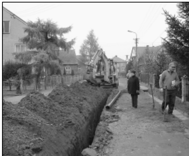
Budowa wodociągu w Uściu.
