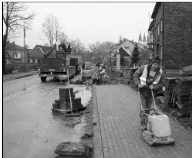
Budowa chodnika w Szczurowej.
