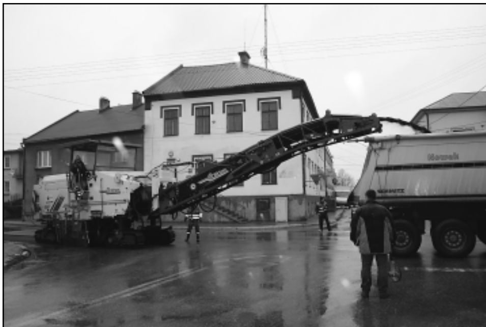
Frezowanie nawierzchni na skrzyżowaniu w Szczurowej.
