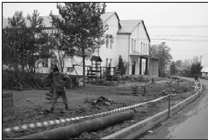
Budowa chodnika w Niedzieliskach.
