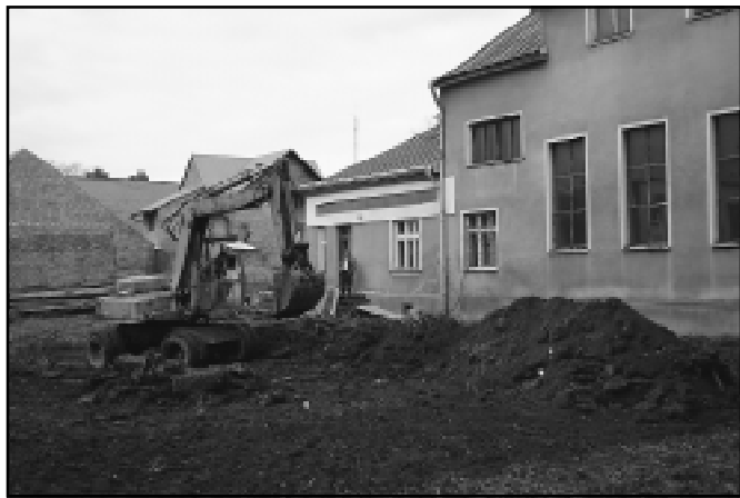
Pierwsze prace przy wyrównywaniu terenu.
