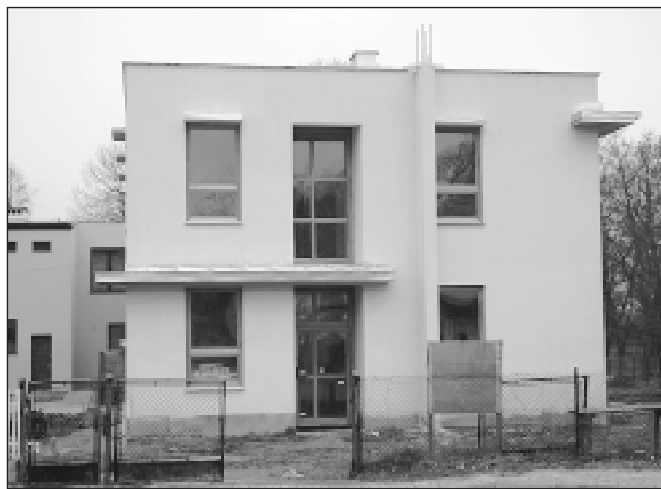
W Szczurowej trwa budowa posterunku policji.
