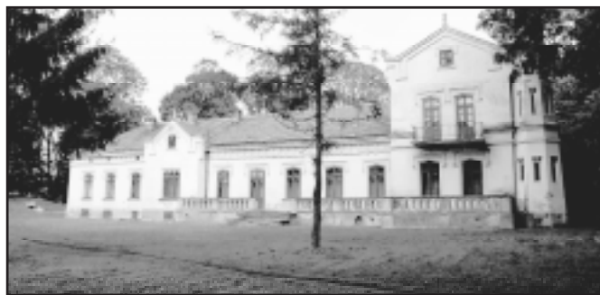
Dwór w szczurowskim parku będzie remontowany
