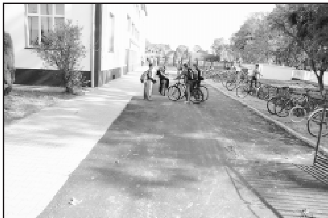
Zmodernizowany wjazd w Szczurowej
